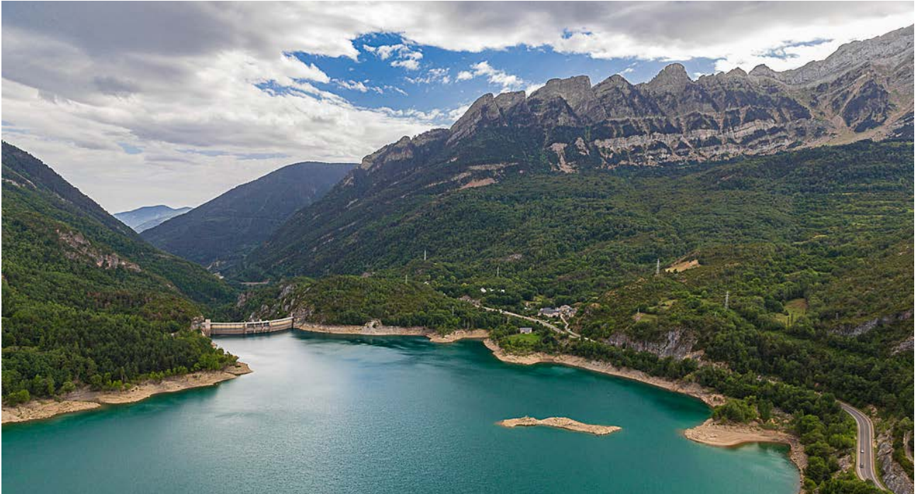
Réservoir de Bubal. Source: Etienne Valois
